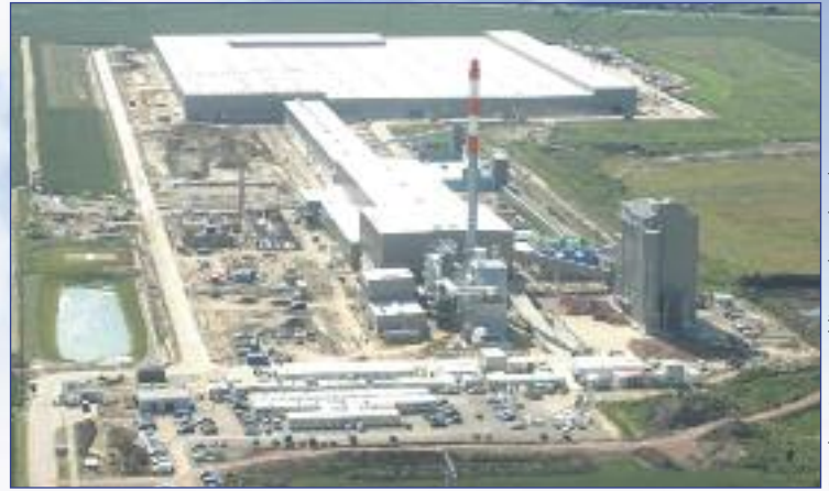
Standort Osterweddingen (Bauphase)
