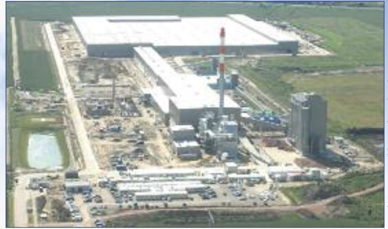
Standort Osterweddingen (Bauphase)
